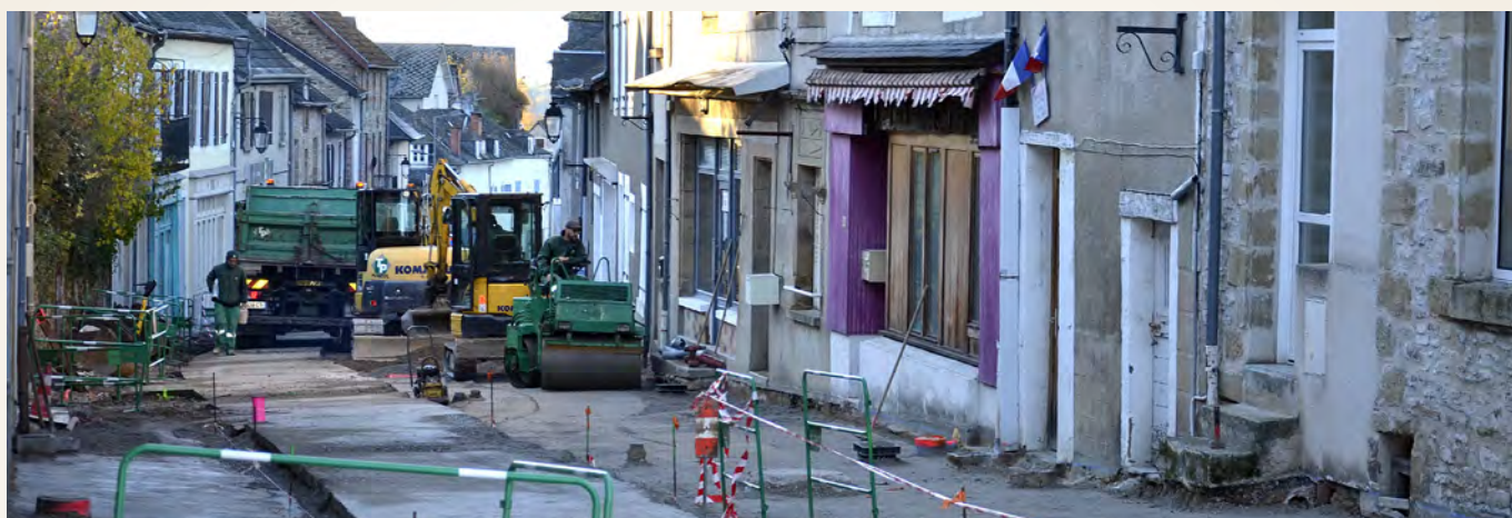
Les travaux d'aménagement de la rue Jean Moulin
