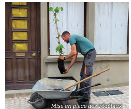
Mise en place des végétaux
